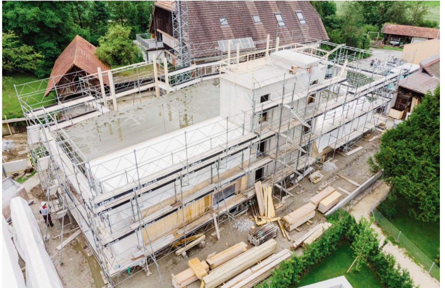
Die spezielle Bauart ist im Rohbau nur in Details ersichtlich, dabei werden immerhin 150 Kubikmeter Truber Holz verbaut. Matthias Käser
